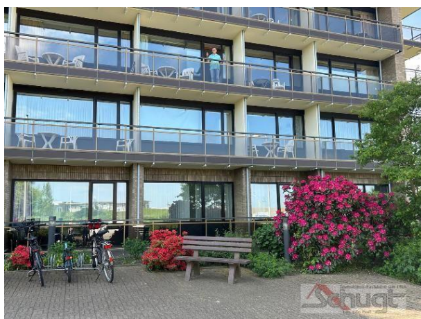
Ansicht von außen
